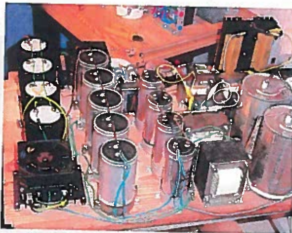
Der skal strøm og spænding til. Et hav af kondensatorer i RC-koblinger. Længst til højre skimtes den kolossale nettrafo og 2 stk. 47 uF/2.200 volt kondensatorer, klunset fra gamle kopi-maskiner.
